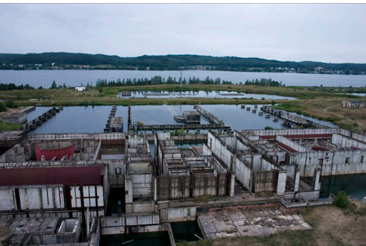
Недостроенная АЭС Жарновец, расположенная на севере Польши в 50 км северо-западнее Гданьска
