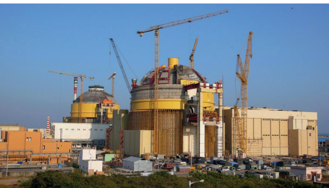
Строительство АЭС Куданкулам, 2009 г.
